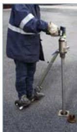
Esempio di utilizzo su una valvola interrata
